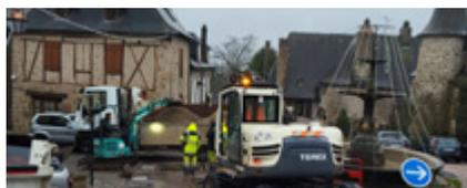
Les travaux de sectorisation du réseau d'eau potable sont en cours. Ils permettront d'isoler un secteur en défaut sans couper l'eau pour l'ensemble des usagers.
