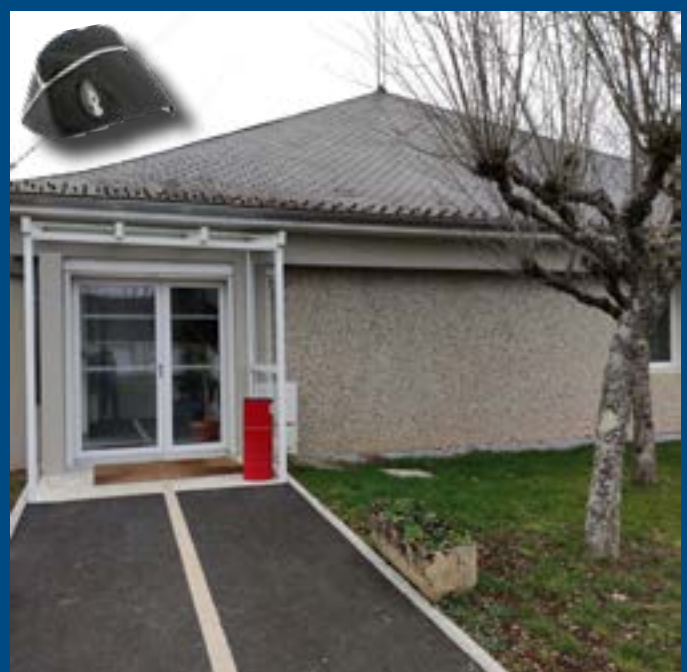
2022 : restructuration des locaux et construction de garages et logements
