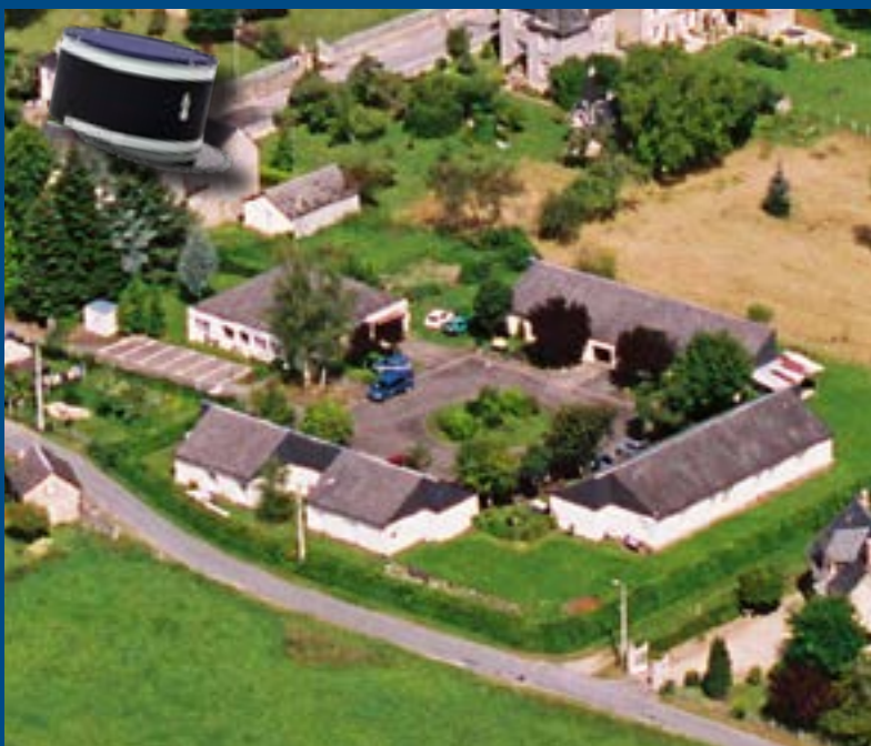
Nouveaux bâtiments rue de Panazol suite à la démolition des anciens locaux
